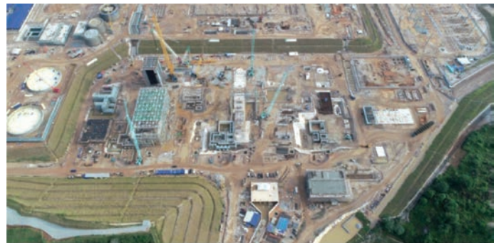
Kemajuan Pembangunan Edra Energy Sdn Bhd (April 2019) Edra Energy Sdn Bhd Site Progress (April 2019)
