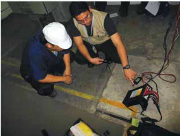
Pegawai ST sedang memeriksa kejanggalan yang ditemui dalam pembacaan kadar penggunaan elektrik
