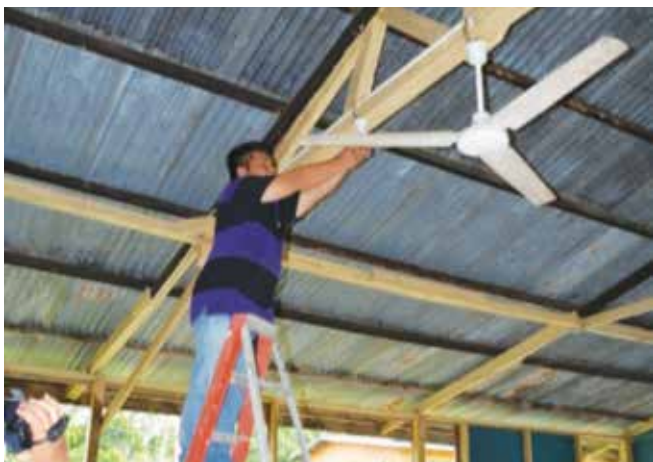
Pendawaian elektrik sedang dilakukan
