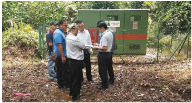
Pemeriksaan ke atas aktiviti Orang Kompeten dan pemasangan elektrik di Taman Botani, Shah Alam
