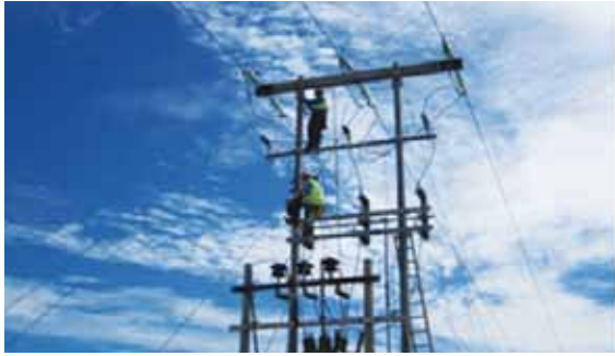
Kerja-kerja di Talian Atas 33 kV H-POLE PKSJ 17, Stesen Setiu, Terengganu
