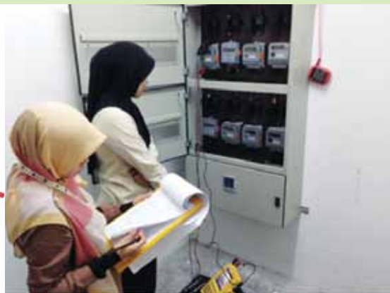
Pegawai ST sedang melakukan pengujian meter di premis pengguna
