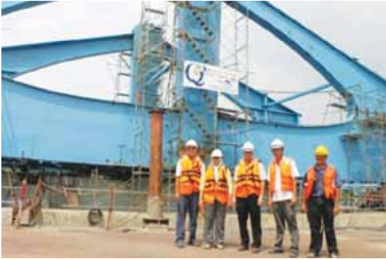
Lawatan ke pemasangan Projek Swing Bridge Keretapi Tanah Melayu Berhad, Butterworth, Pulau Pinang
