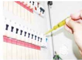
Kegagalan PAB berfungsi mengakibatkan tiada perlindungan daripada arus bocor ke bumi.
