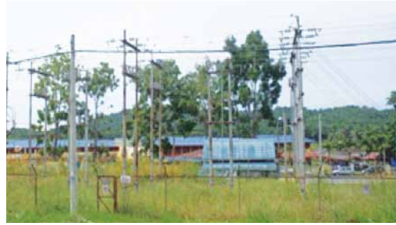
Kerja-kerja pembaikan talian atas voltan rendah dijalankan dengan kawalan keselamatan.
