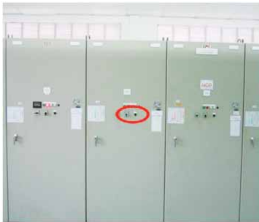
Penunjuk dan lampu penunjuk hendaklah sentiasa dipastikan betul dan berfungsi untuk menunjukkan status terkini bekalan papan suis sama ada dalam keadaan on atau off .
