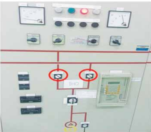
Penunjuk dan lampu penunjuk hendaklah sentiasa dipastikan betul dan berfungsi untuk menunjukkan status terkini bekalan papan suis sama ada dalam keadaan on atau off .
