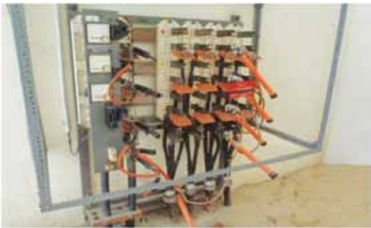
Litar pada panel voltan rendah hendaklah dibumikan dengan sempurna, seluruhnya tanpa termasuk litar- agihan pengguna supaya disambung ke bumi dibuat dengan berkesan.
