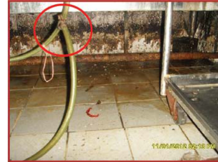
Kaedah sambungan hos yang tidak dibenarkan dan penggunaan jenis hos yang tidak bersesuaian
