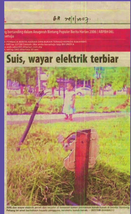
Gambar 4 : Isu melakumuskan (vandalism) di mana suis dan wayar elektrik terdedah adalah merbahaya.
