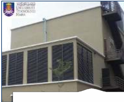
UiTM Sg. Buloh DCS Plant
